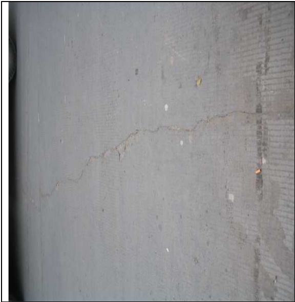
Se muestra grietas del pavimento
