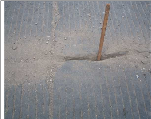
Se observa el estado de las juntas
