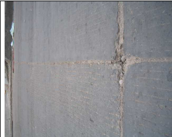
Se observa el estado de las juntas
