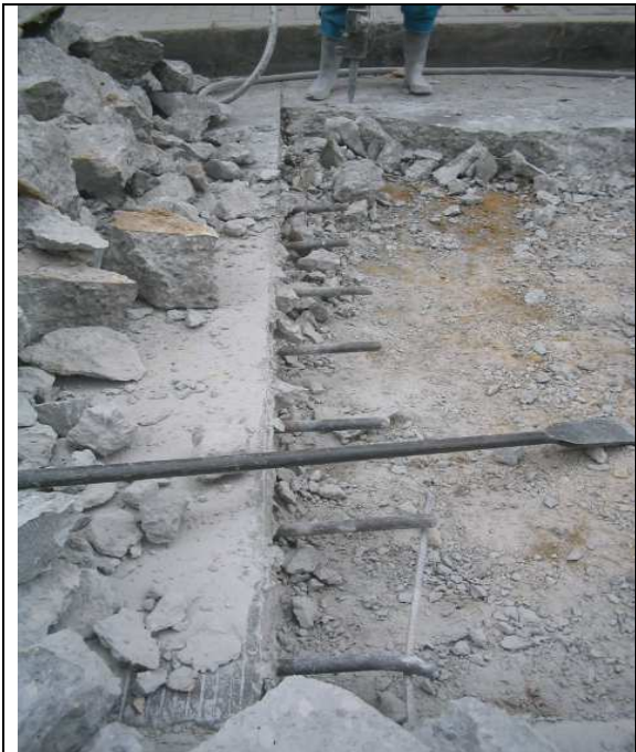
Se observa placas en demolición en el mismo sector, como consecuencia de las grietas
