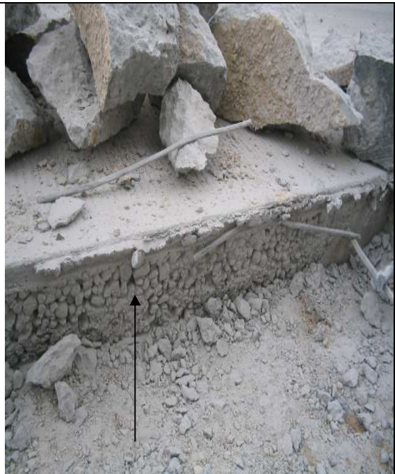
Placa demolida y el hormiguero de la losa del lado por mala fundición.
