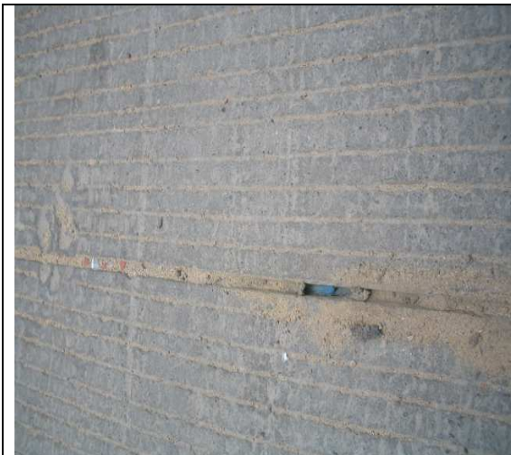
Se observa el sellante de las juntas
